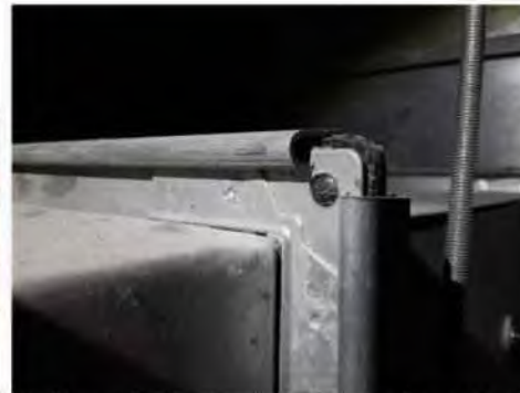
Foto 24: ventilatiekanalen, de verbindingen zijn gevuld met foam en zijn niet asbestverdacht.
