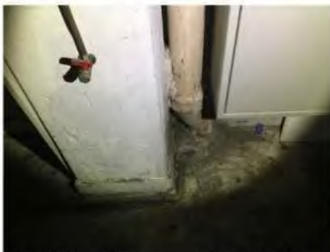
Foto 29: leidingwerk installatieruimte Stadhuisbrug 5, geen asbestverdachte toepassingen aangetroffen.
