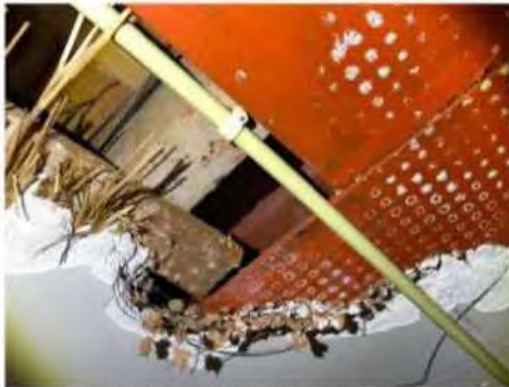
Foto 25: de originele plafonds zijn stucwerk op riet en rondom de stalen constructie is stucwerk op gaas toegepast. Er zijn geen asbestverdachte toepassingen aangetroffen.
