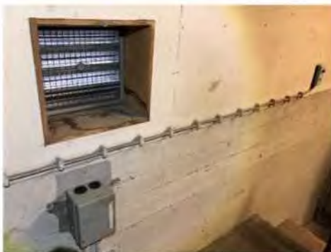
Foto 17: doorvoer liftmachinekamer 1 (bezoekers).
