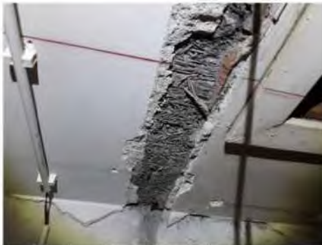
Foto 23: opbouw plafonds vierde verdieping, geen asbestverdachte toepassingen aangetroffen.
