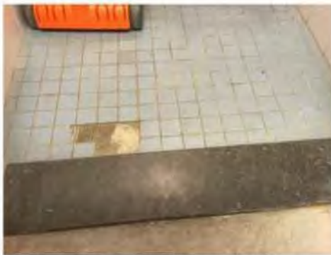
Foto 27: vloerafwerkingen, geen asbestverdachte toepassingen aangetroffen.
