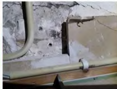
Foto 22: ruimte boven systeemplafonds, geen asbestverdachte toepassingen aangetroffen.
