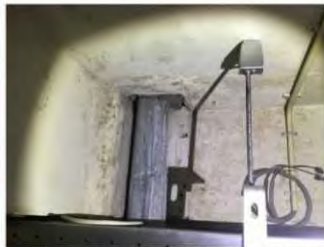
Foto 28: bouwkundige schacht toilet Stadhuisbrug 5, geen asbestverdachte toepassingen aangetroffen.
