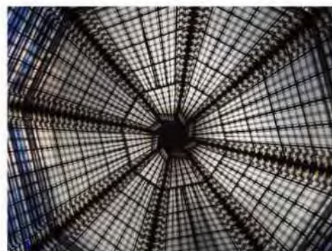
Foto 12: onderzijde lichtkoepel, geen asbestverdachte toepassingen aangetroffen.
