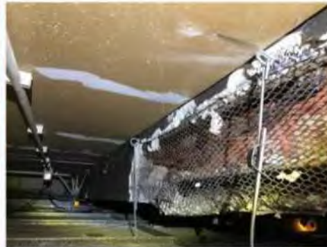
Foto 26: stucwerk op gaas rondom stalen constructie.
