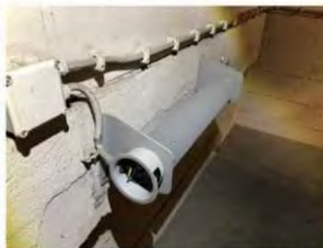
Foto 16: ribbuis kachel liftmachinekamer 1 (bezoekers), geen asbestverdachte toepassing.
